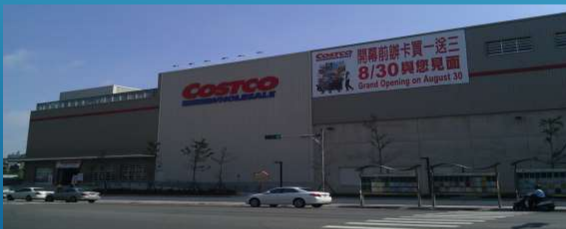
工程名稱：好市多桃園南崁店 產品：高、低壓配電盤
