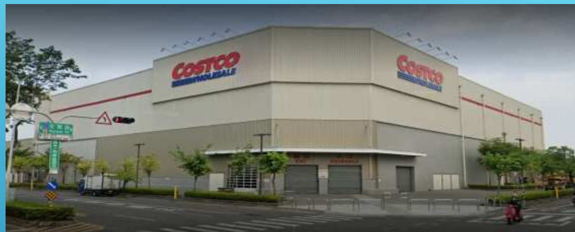
工程名稱：好市多台南店 產品：高、低壓配電盤
